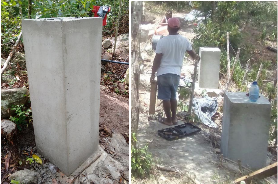
Fig 6 Pedestales puente en K1-160
