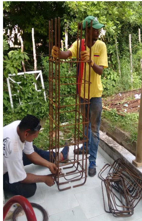
Fig 3 Corte y figuración de acero
