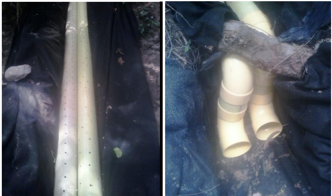
Fig 7 Construcción de filtro entre K1-160 y K1-400
